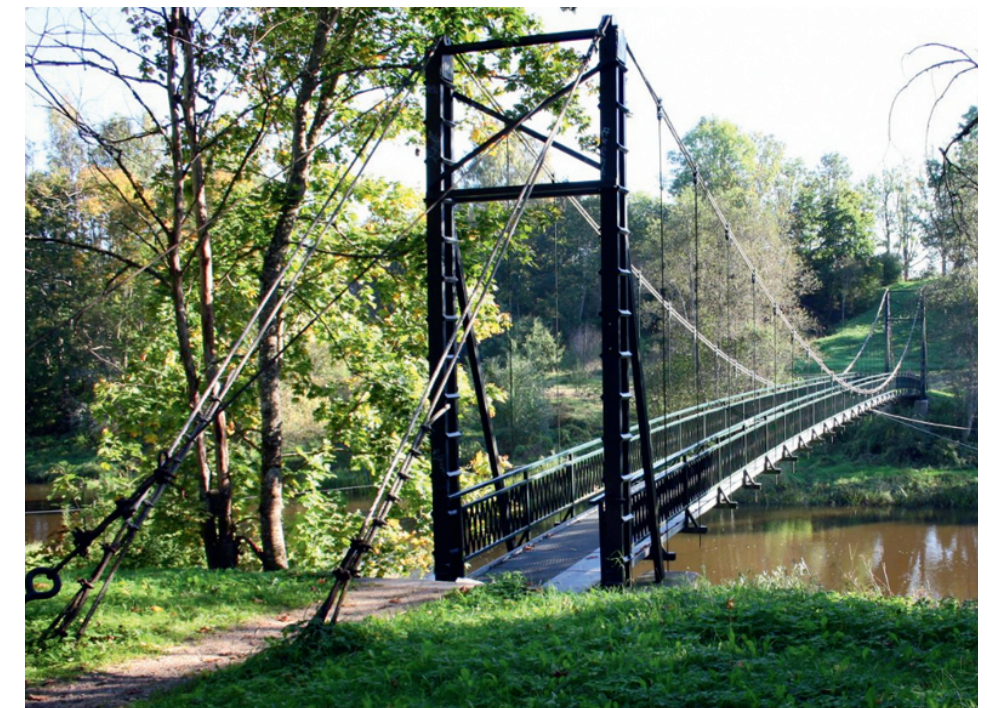
Līdzīga konstruktīvā shēma ir daudziem Latvijā būvētiem gājēju trošu tiltiem.
