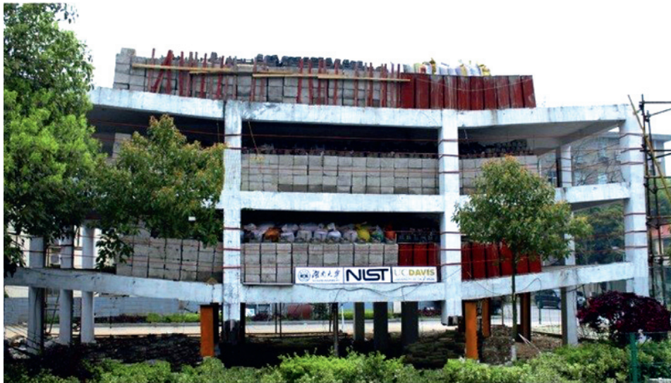
Attēlā redzama pilna izmēra slodzes pārbaude konstrukcijai, kuras progresējošā sabrukuma novēršana organizējama pēc saistīšanas metodes, aprēķiniem izmantojot alternatīvu slodžu ceļu metodi. Attēls no ascelibrary.org
